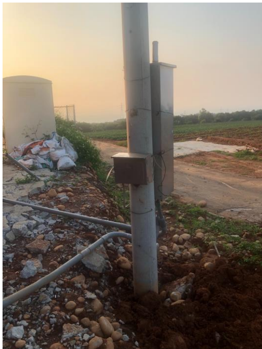
電線桿遷移工程
