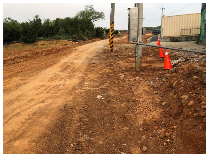
電線桿遷移工程
